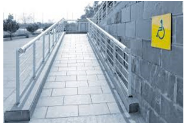
Được lắp đặt biển báo
